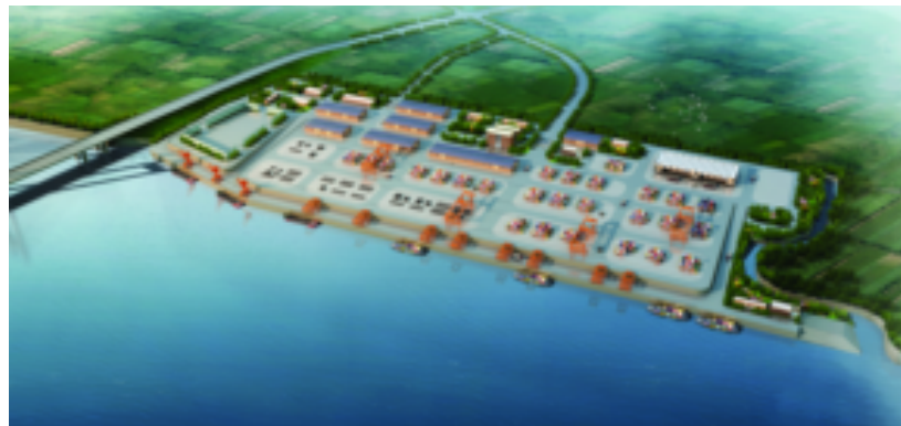
龙游港区桥头江作业区项目
