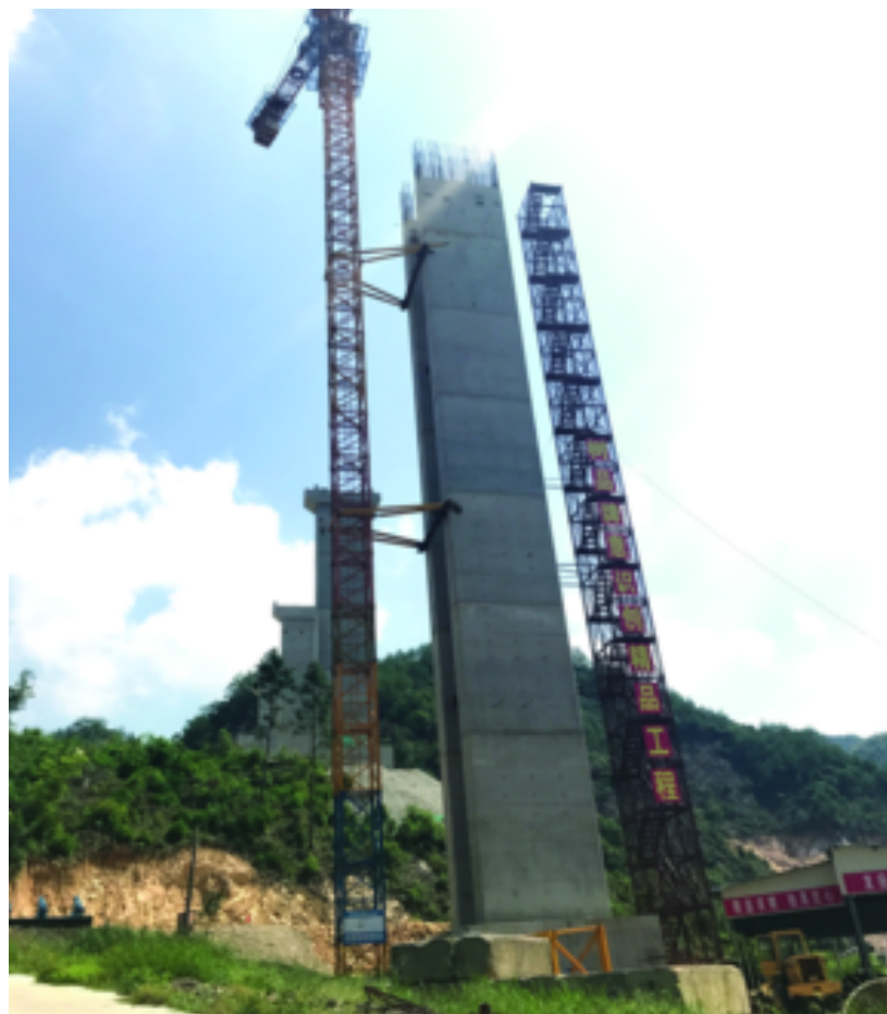
建设中的高坪桥水库库区公路改(复)建工程
